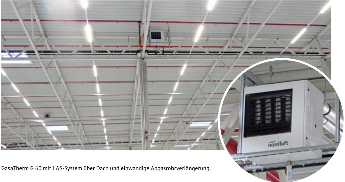
GasaTherm G 60 mit LAS-System über Dach und einwandige Abgasrohrverlängerung.
