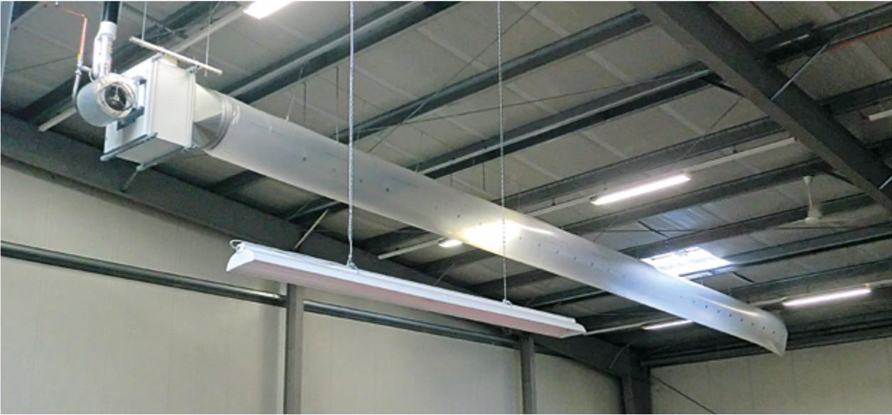
Beheizung Produktionshalle: GasTherm K mit Luftverteilung über Folienschlauch (Sonderzubehör).
