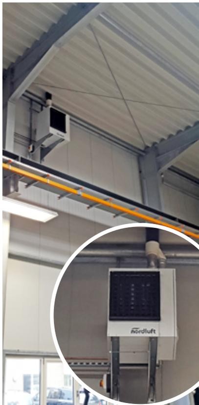
Beheizung Produktionshalle: GasaTherm K und LAS-Abgasführung über Dach.
