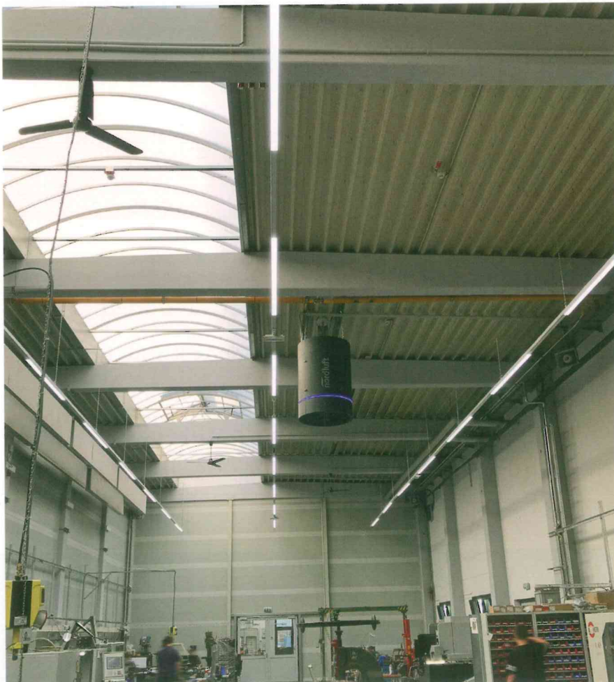
Bild 1: Der INVERSO im Einsatz
