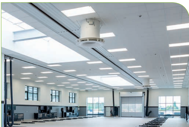
Abluftansaugung und Zuluftbringung direkt unter der Hallendecke – durch große Zuluftwurfweite keine Kurzschlussgefahr
