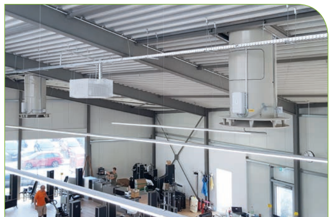
Abluftansaugung und Zuluftbringung direkt unter der Hallendecke – durch große Zuluftwurfweite keine Kurzschlussgefahr
