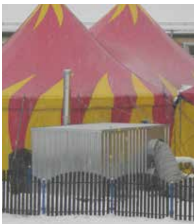
Beheizung Zirkuszelt: Einbau NL-A in transportablen Container.
