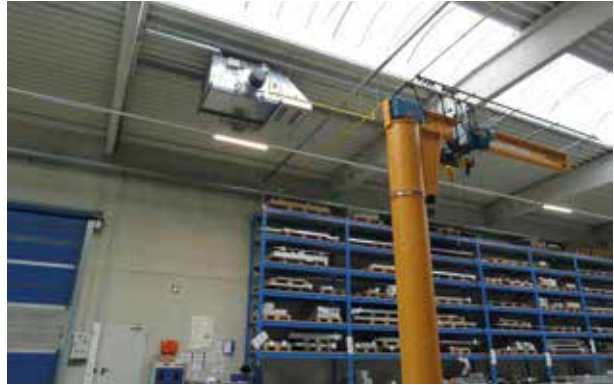
NL-A Deckengerät mit Gerätegrundrahmen für Deckenabhängung.
