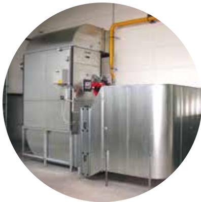
NL-A 430 mit Standgerüst, Ansaug-Filter, Ansaug-Schalldämpfer.
