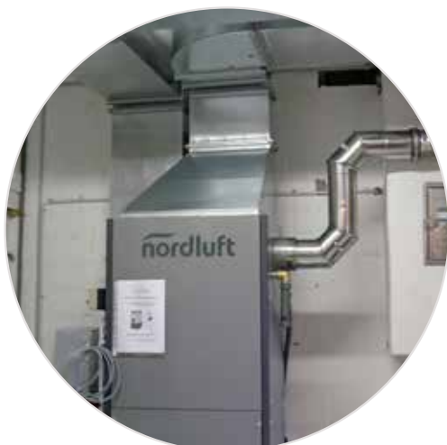
Zuluftanschluss und Abgassystem eines NL-A WO
