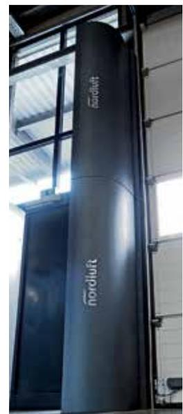
Vertikale Installation von zwei TLS-IV 2,0
