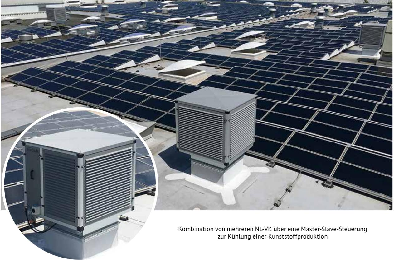
Kombination von mehreren NL-VK über eine Master-Slave-Steuerung zur Kühlung einer Kunststoffproduktion
