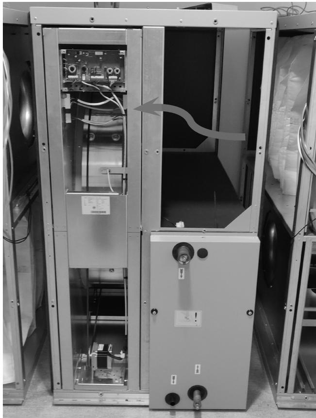
Prostrčte napájecí kabel s průchodkou do prostředního modulu do prostoru regulace.
