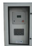
Optionales Steuergerät für die Verwaltung von Anlagen mit Absorptionseinheiten und integrierten Brennwertheizkesseln von Robur.
